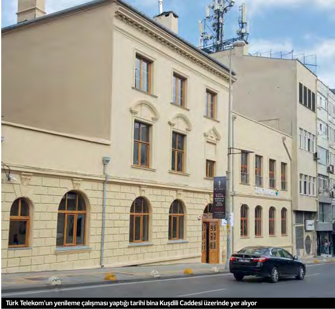
Türk Telekom'un yenileme çalışması yaptığı tarihi bina Kuşdili Caddesi üzerinde yer alıyor
