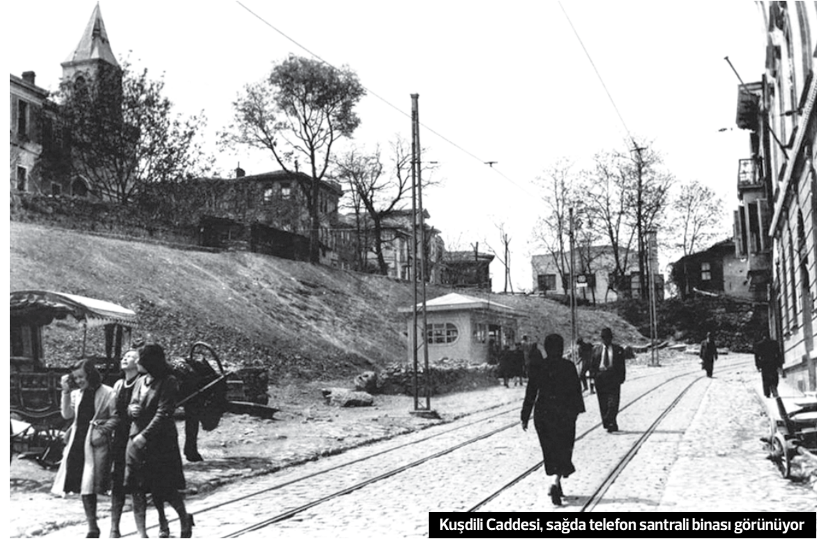
Kuşdili Caddesi, sağda telefon santrali binası görünüyor
